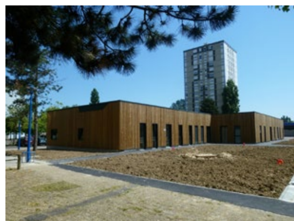
Réhabilitation partielle en pôle santé
