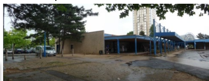
Le centre commercial du Lac avant les travaux
