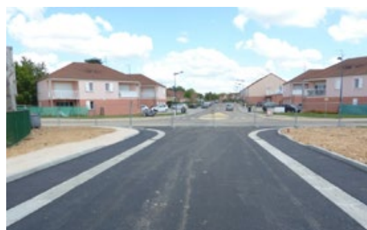
Travaux de viabilisation
